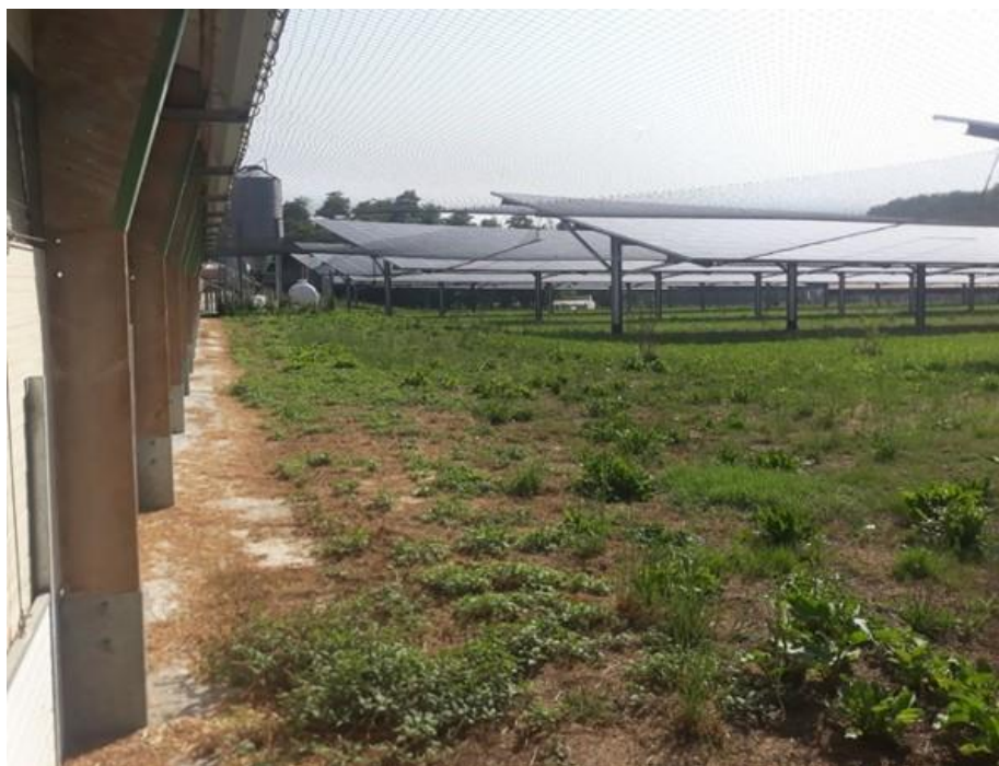
Figure 9 : Photographie d'une volière photovoltaïque de Technique Solaire dans le cas d'un élevage de poulets de chair, avec à gauche le bâtiment d'élevage relié directement aux panneaux solaires et à la clôture périphérique, formant un clos total.
