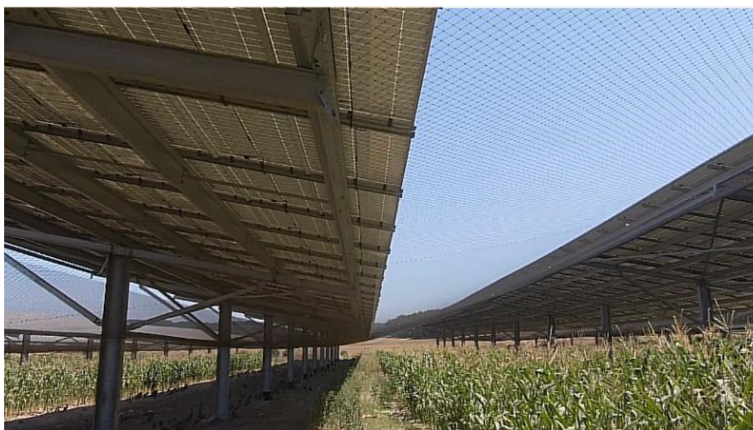
Figure 7 : Photographie d'une volière agrivoltaïque développée par Technique Solaire avec l'aménagement du parcours extérieur avec des rangs de maïs
