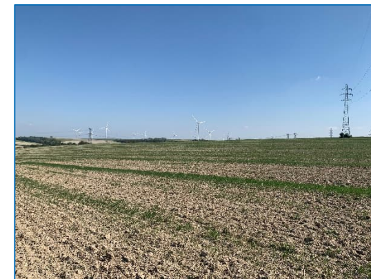
Figure 7 : Arrivée à travers champs au poste de SEUIL
