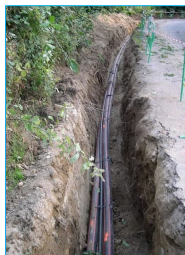
Figure 15 : Tranchée avec fourreaux PEHD
