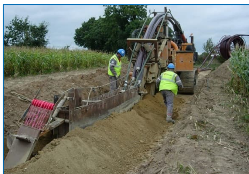
Figure 16 : Mise en place de fourreaux PEHD en zone agricole à l'aide d'une trancheuse
