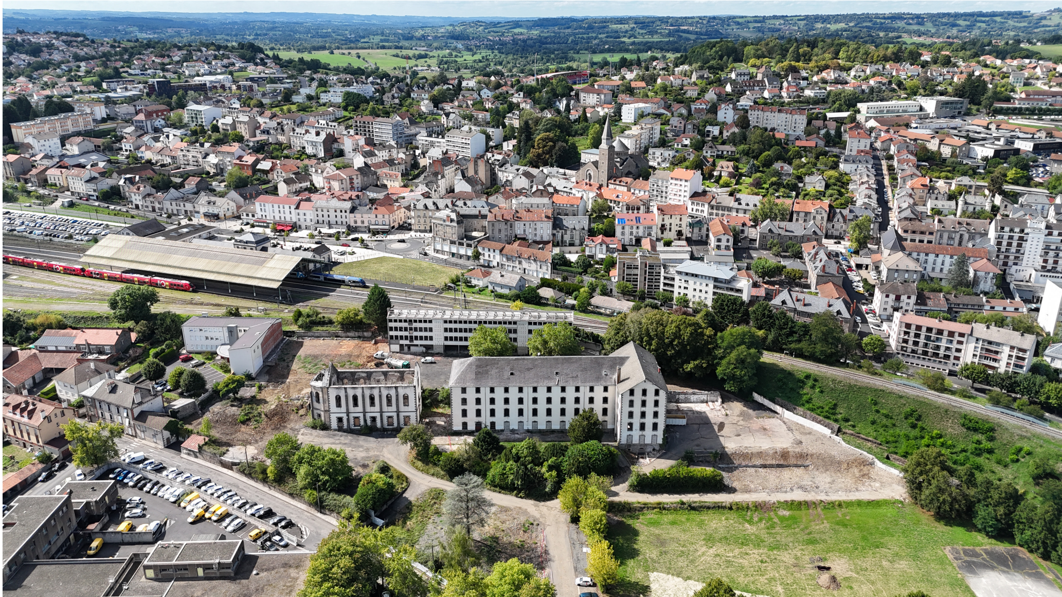
Vue Est - Prise en drone le 9 septembre 2025
