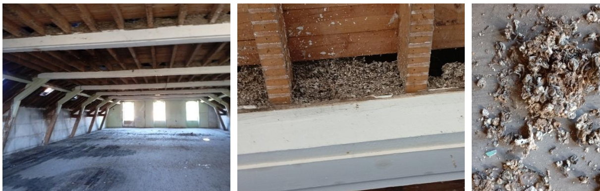
L'extrémité Nord des combles et le faux plafond.
