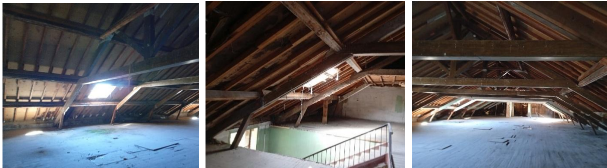
Sur la plus grande partie de la surface, le faux plafond des combles a été évacué.
