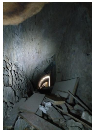
Le sous-sol dans sa partie Ouest.
