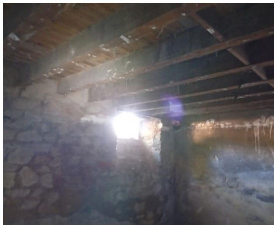
Le sous-sol dans sa partie Nord-Est.
