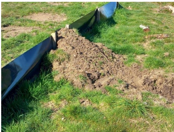
Figure 6 : Exemples de filets de protection pour limiter l'accès de la petite faune à un chantier (ENCIS Environnement)
