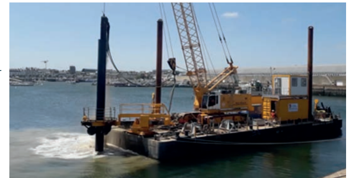
Fig. 30 - Illustration d'un panache de turbidité généré par le battage de pieux (Merceron)
