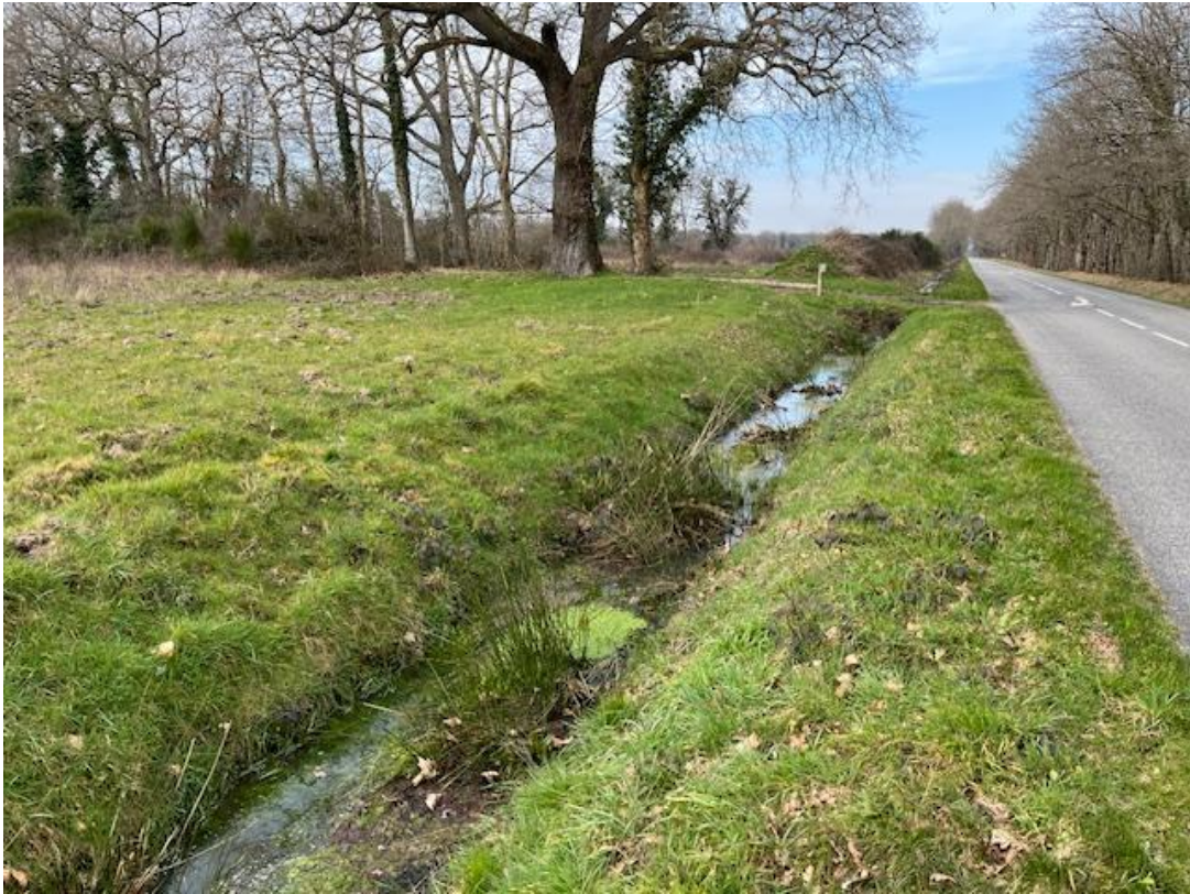
Figure 7 : Vue en direction du Nord-Nord-Ouest et aperçu de l'accès à la parcelle depuis la RD126
