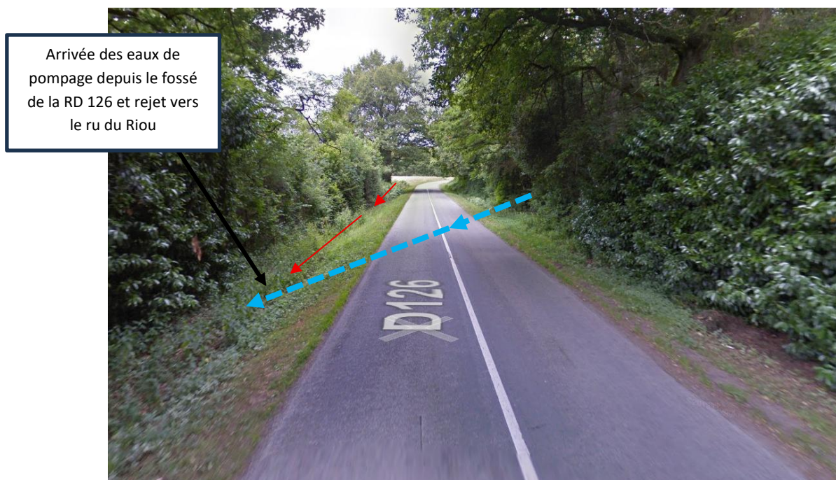
Figure 9 : Vue en direction du Nord du tracé du ru le Riou passant en busage sous la RD 126 et du point de rejet des eaux de pompage via le fossé de la RD 126
