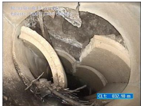
Figure 6 : Ovalisation dû à un écrasement de la conduite (gauche) généralisé sur le linéaire, effondrement ponctuel en partie aval du tronçon (Droite), Source: Drivetec Sud, 2020)
