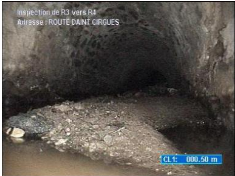
Figure 5 : Ouvrage route sous la route de Saint-Cirgues (Drivetec Sud, 2020)
