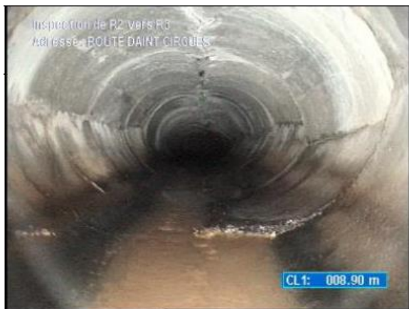
Figure 6 : Ovalisation dû à un écrasement de la conduite (gauche) généralisé sur le linéaire, effondrement ponctuel en partie aval du tronçon (Droite), Source: Drivetec Sud, 2020)
