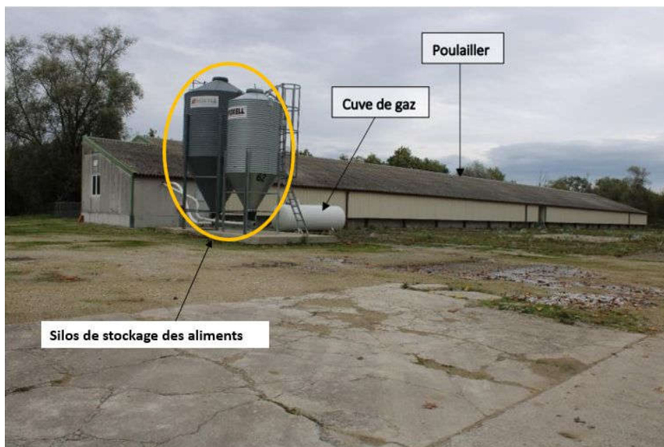
Photo 5.1 : Les bâtiments d'élevage existant
