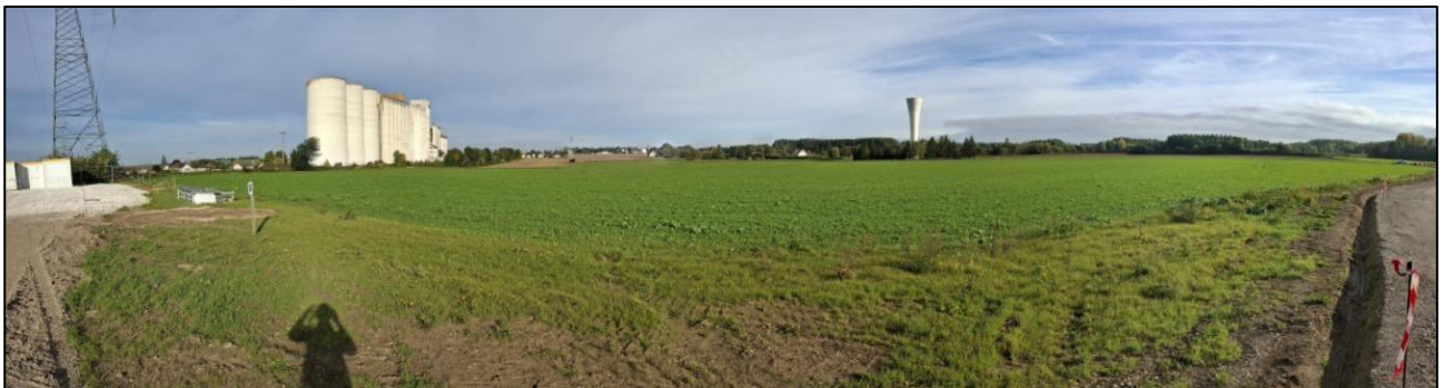
Figure 7 : Vue générale sur le site d'étude – Vue vers le Nord
