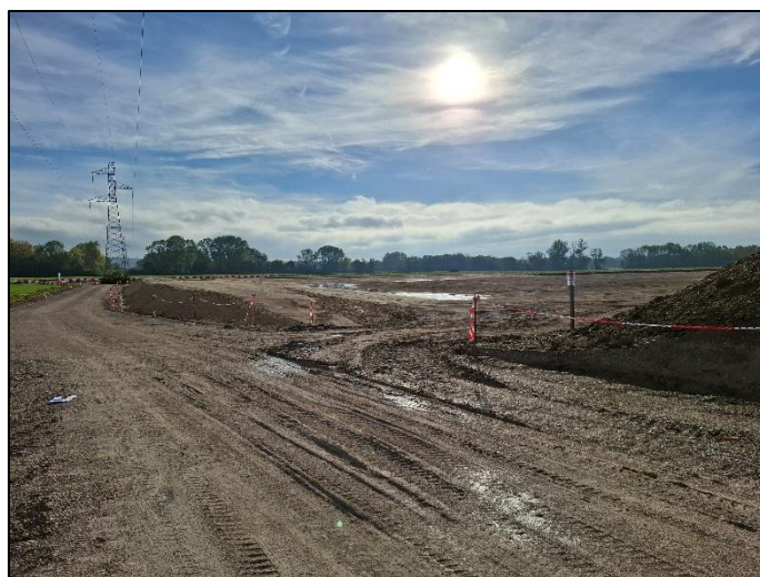
Figure 9 : Future plateforme SNCF – Création d'un poste de haute tension
