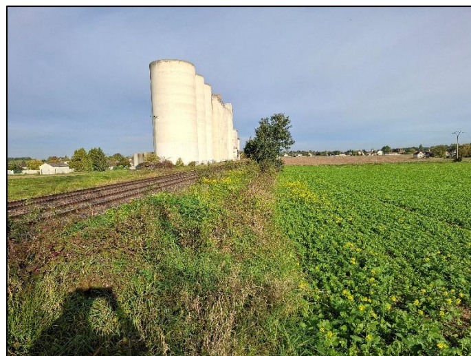
Figure 8 : Voie ferrée à l'Ouest du site – Barrière aux écoulements
