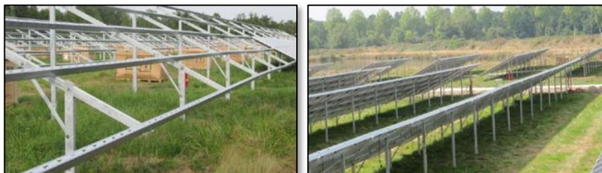
Figure 37 : Impacts faibles sur un terrain humide suite à la pose des structures et modules
