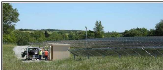
Figure 47 : Opération de maintenance
