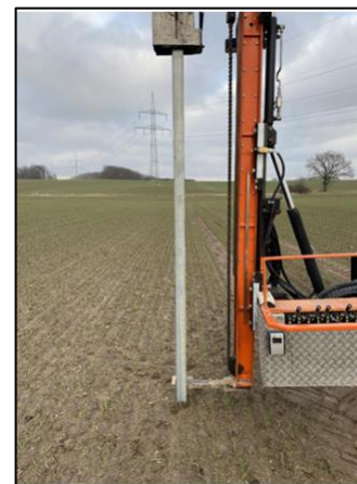
Figure 30 : Battage des pieux
