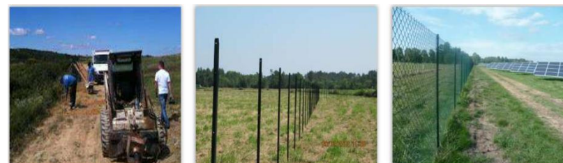
Figure 35 : Mise en place de la clôture (pose des ancrages, des piquets et du maillage)
