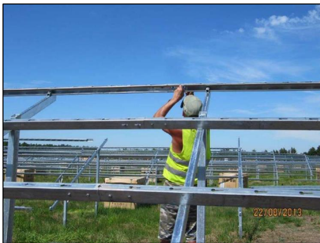
Figure 27 : Systèmes de fixation pour installation photovoltaïque
