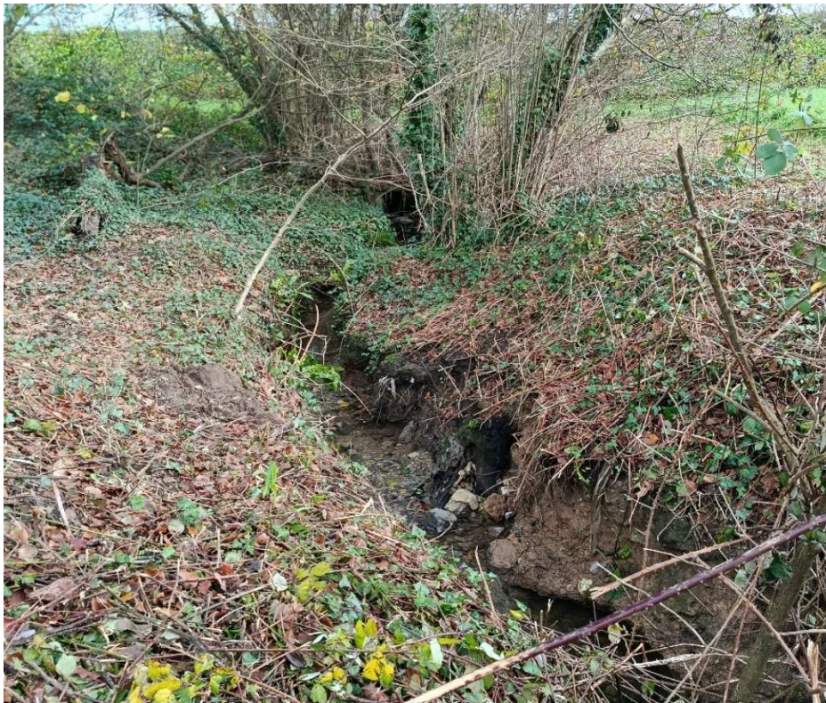
Fig 17 : photo 14 vue du ruisseau en contrebas du lot 5 au sud
