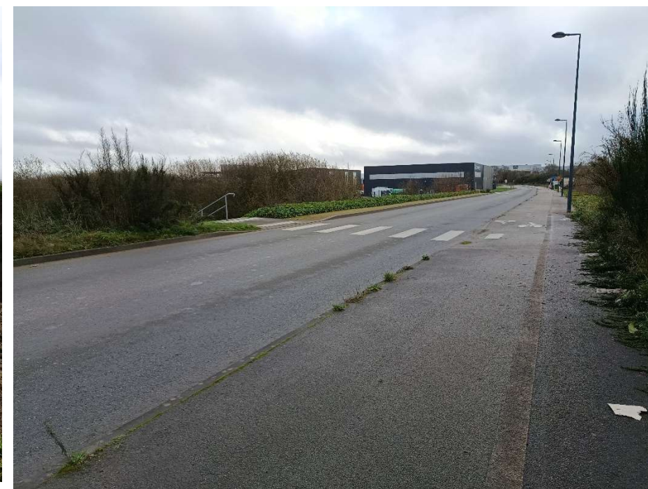
Fig 10: photo 9 vue du chemin piéton faisant la liaison entre les 2 lots
