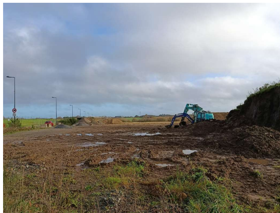
Fig 9: photo 8 vue du lot 3/4 au nord-est de la parcelle
