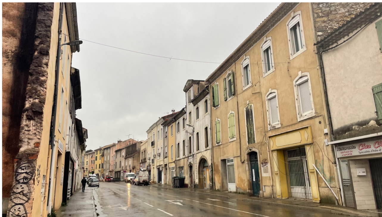
Photo 2 : Vue de la rue du Faubourg du Soleil – Nord - 10/12/25
