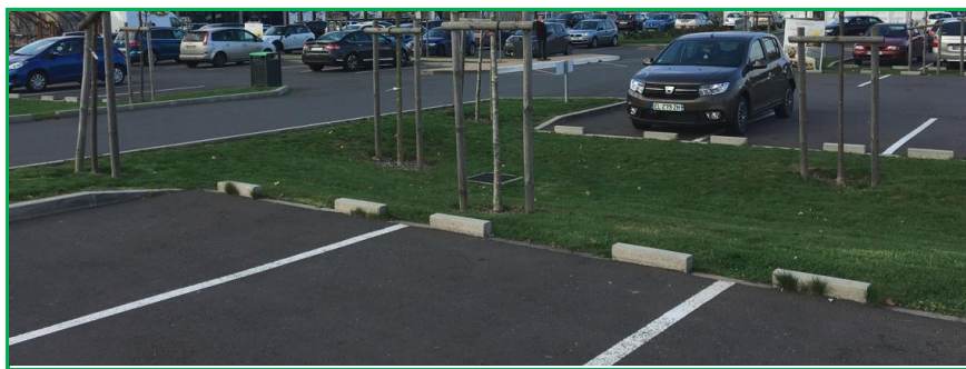
Requalification d'un parking injection dans les massifs drainants par les noues. Yutz - Zac Meilbourg
