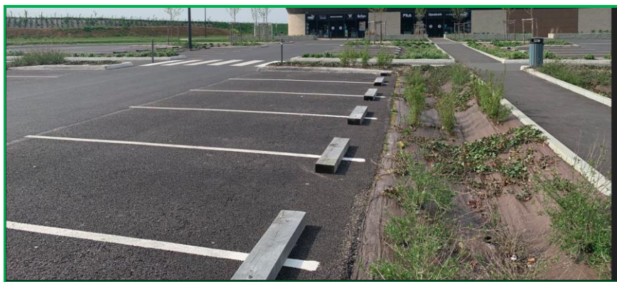
Requalification d'un parking injection dans les massifs drainants par les noues. Franqueville saint pierre- Secteur du VAL Grêle
