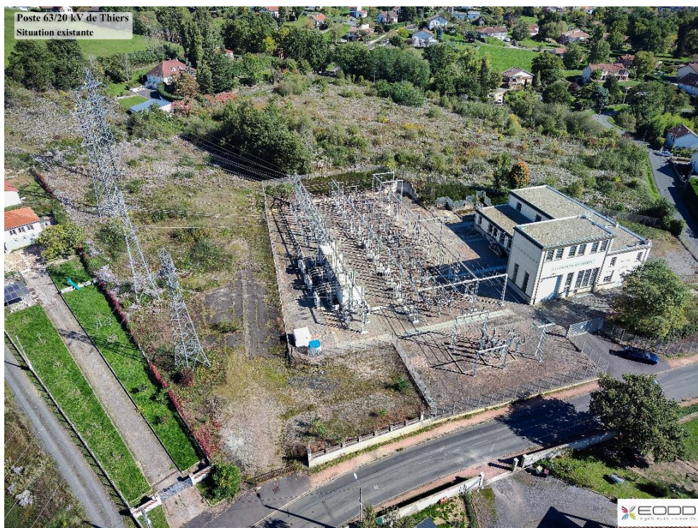
Illustration 7 : Vue aérienne du poste existant
