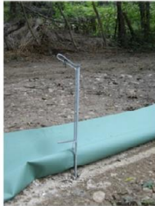
Photos 19 et 20 : Un exemple, en cours de montage sur la voie RN 57 des Mercureaux (en 1999) de « kit » de dispositif de protection temporaire qui comprend une bâche polyester de 50 cm de large, des piquets ajustables en hauteur, des éléments de fixation coudés (45°) en partie supérieure pour former un havotet infranchissable à placer tous les 2 m (Source : © M. Gigueux, Cerema Est)
