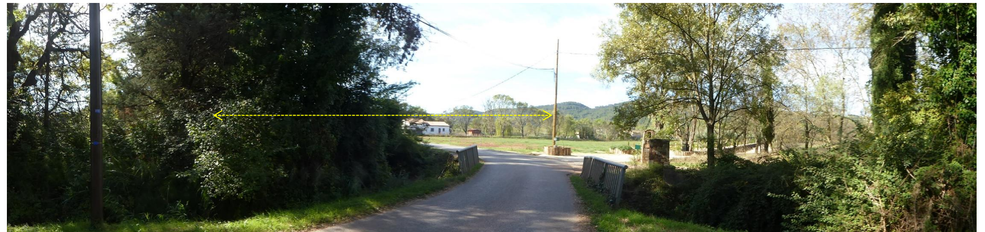
5- Au passage des cours d'eau, la végétation très présente arrête les vues.
