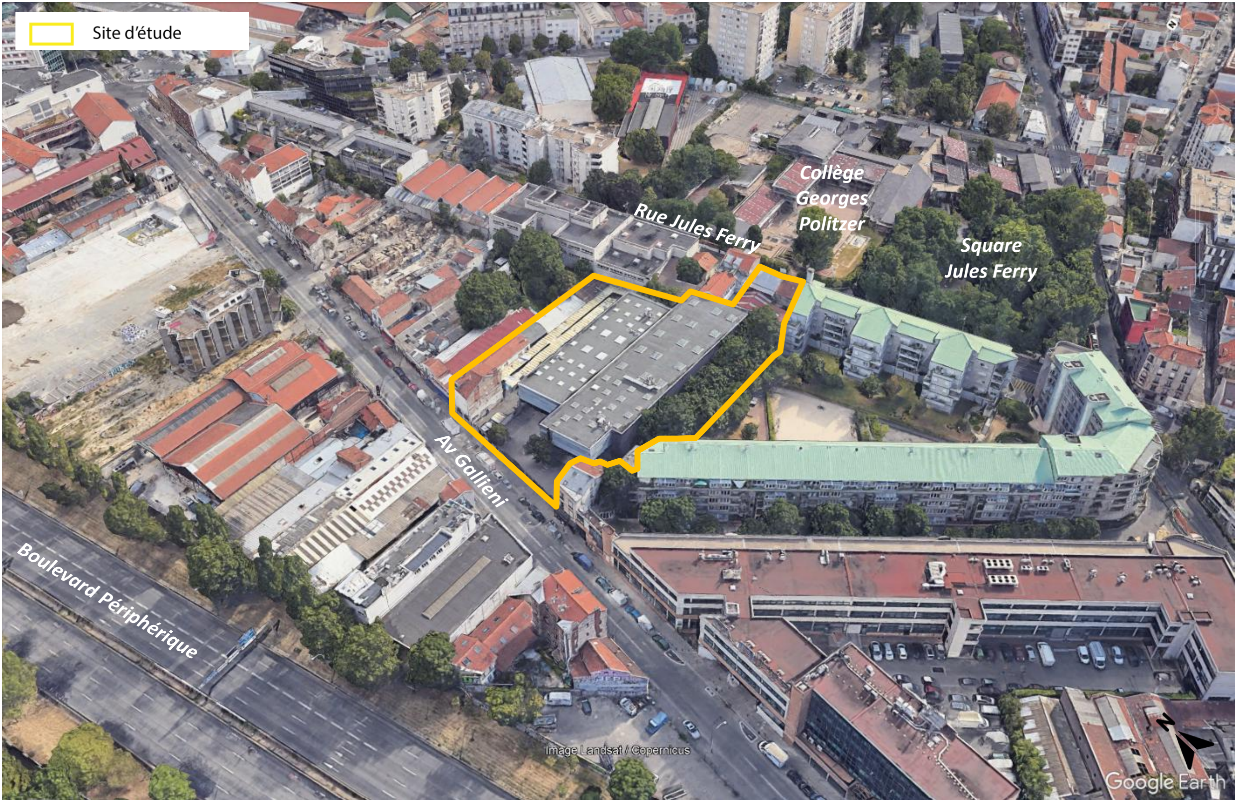
Vue proche de la zone d'implantation – Google Earth 2025
