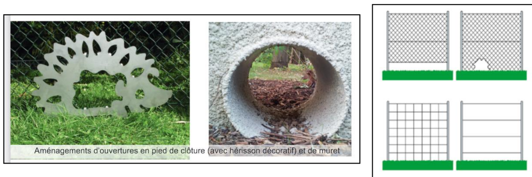
Figure 6. Ouverture de passages sur clôtures et murets -à gauche- et types de grillage adaptés à la circulation de la petite et moyenne faune -à droite- ( Sources : urbanisme-bati-biodiversite.fr et 1001sitesnatureenville.ch )
