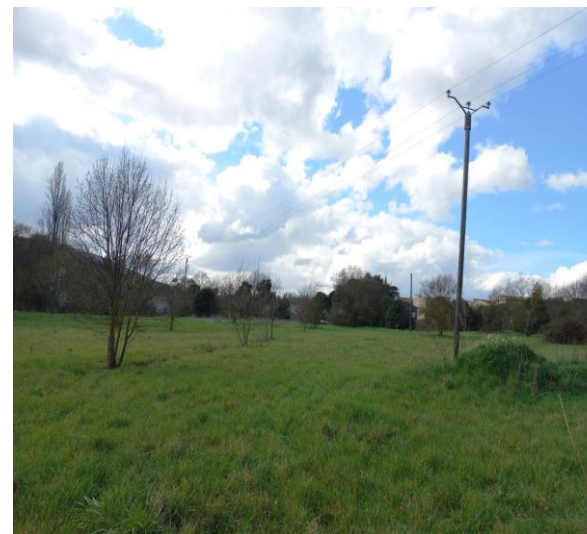
Photographie 6 : Partie Est vers le centre du site / vue sur la ligne électrique en service
