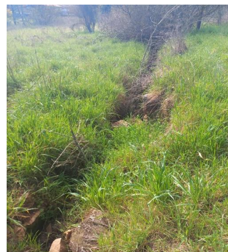
Photographie 8 : Ancien canal d'irrigation au Sud
