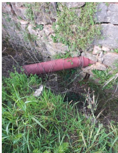
Photographie 11 : Canalisation traversant canal irrigation à environ 20 m au Nord du cours d'eau de l'Aille
