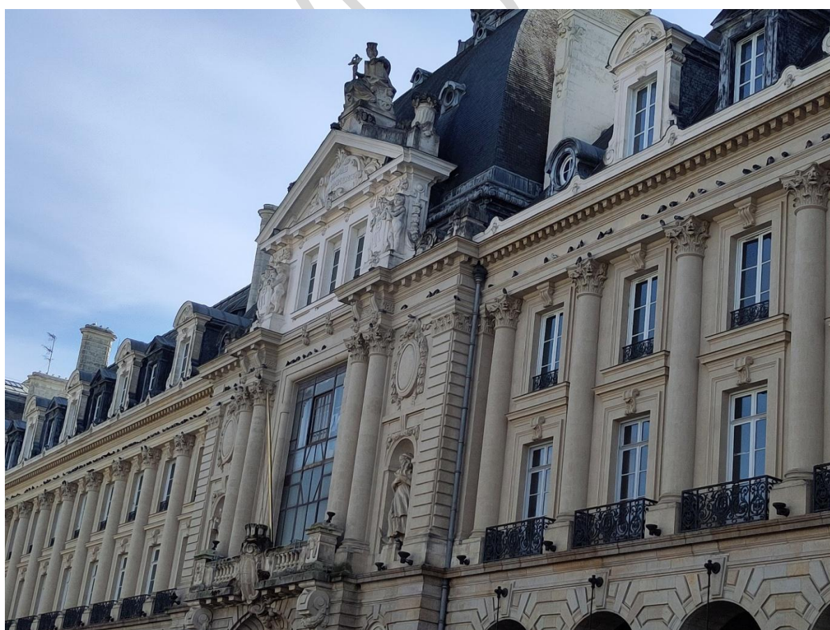
Figure 16 : Illustrations du bâtiment, œil-de-bœuf et façade colonisée par des pigeons (Source : Etamine)
