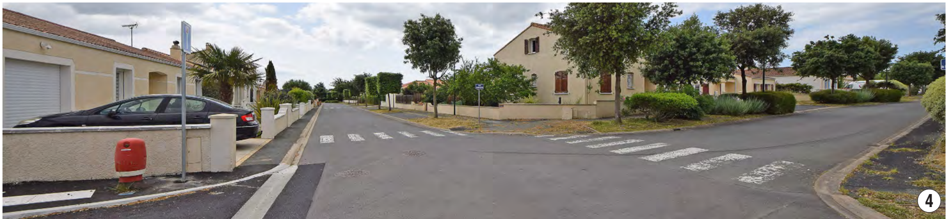
VUE SUD DEPUIS L'INTERSECTION DE LA RUE DU GRAND GALLOCHEAU AVEC LA RUE DE L'ANCIENNE VOIE FERRÉE
