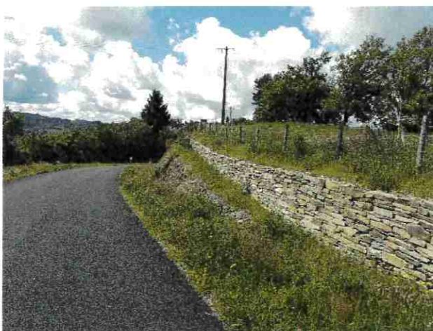
Ici en bordure de la RD573 Le Fel, le mur de soutènement réalisé en pierres sèches s'intègre pleinement dans le paysage et valorise le site.
