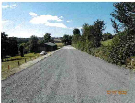
▲ RD138 Elargissement sur un seul côté de la voie qui permet de conserver le linéaire de haie à droite.
