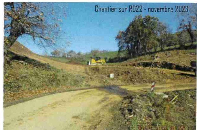
Exemple de décapage réalisé en novembre
