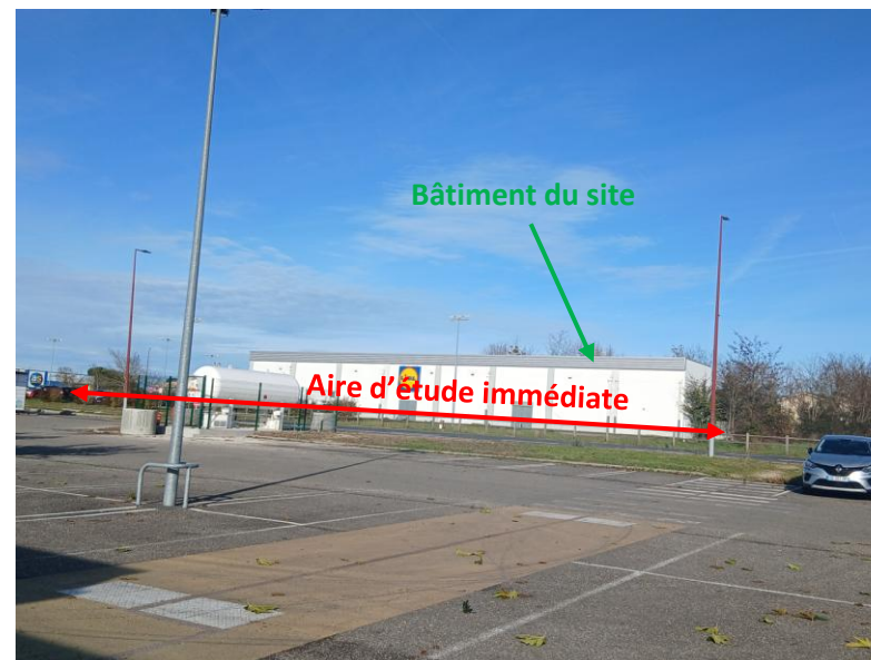
Photographie 2 : Depuis le parking au sud du site
