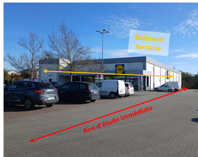
Photographie 4 : Vue du magasin depuis son parking.
