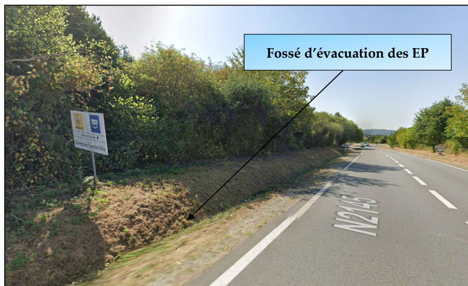
Photo 1 : Fossé le long de la RN 2145
