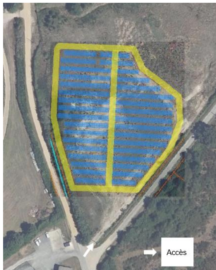
Figure 9 : Accès au niveau de l'ouverture existante
