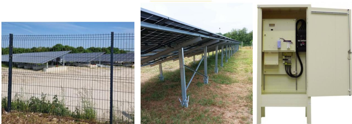
Figure 8 : Illustration de la clôture, des pieux battus, des postes de livraison (source : EDL).
