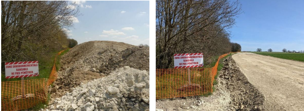
Figure 10 : Exemple de balisage mis en place sur une zone de chantier (source : ECE Environnement)
