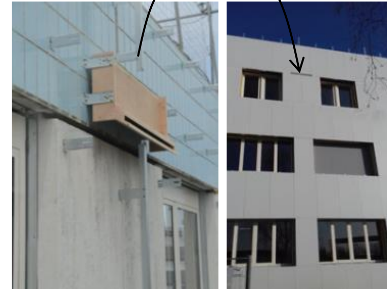
Intégration d'un gîte à chauve-souris dans le bâti (avant-après)
