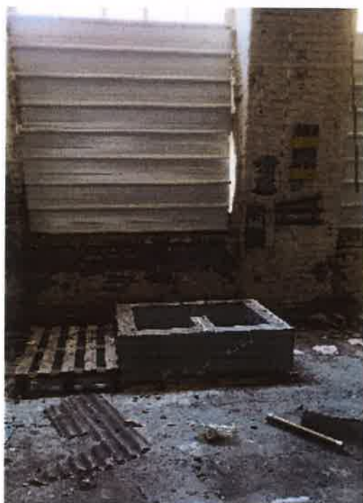
Photo 3 : Emplacement d'un ancien transformateur
