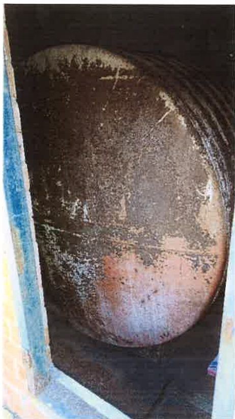
Photo 5 : Cuve observée dans un local isolé (probablement une ancienne cuve de fuel)
