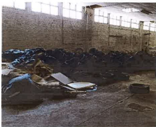
Photo 1 : Tas de pneus dans l'ancien atelier mécanique
