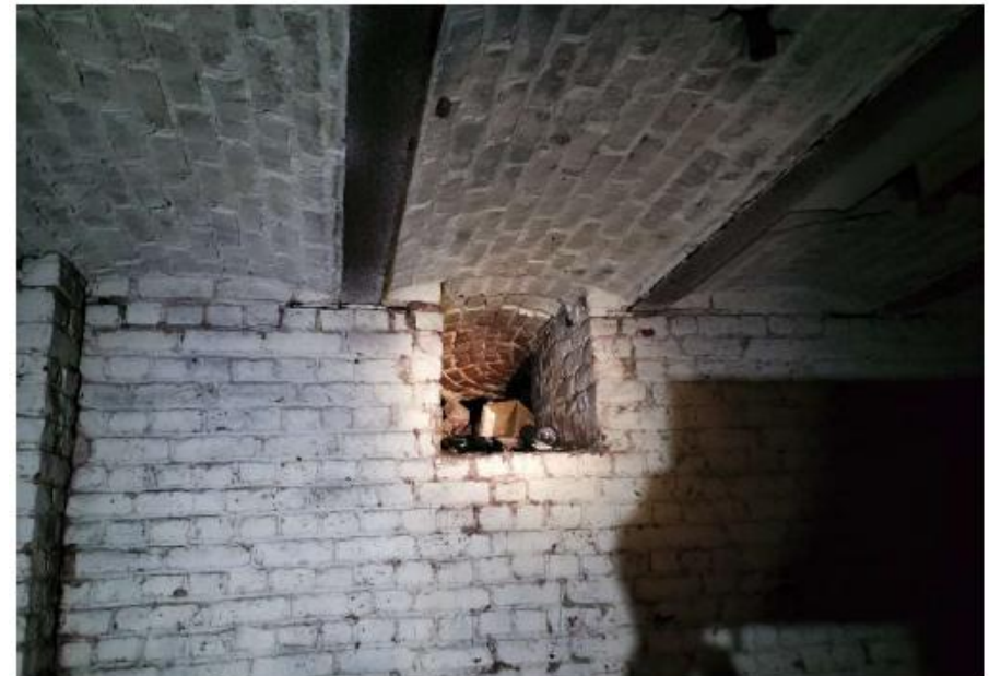
Les disjonctements présents dans les canalisations dans les sous-sols des bâtiments peuvent être utilisés comme gîte d'hibernation (© Biotope, 2023)
