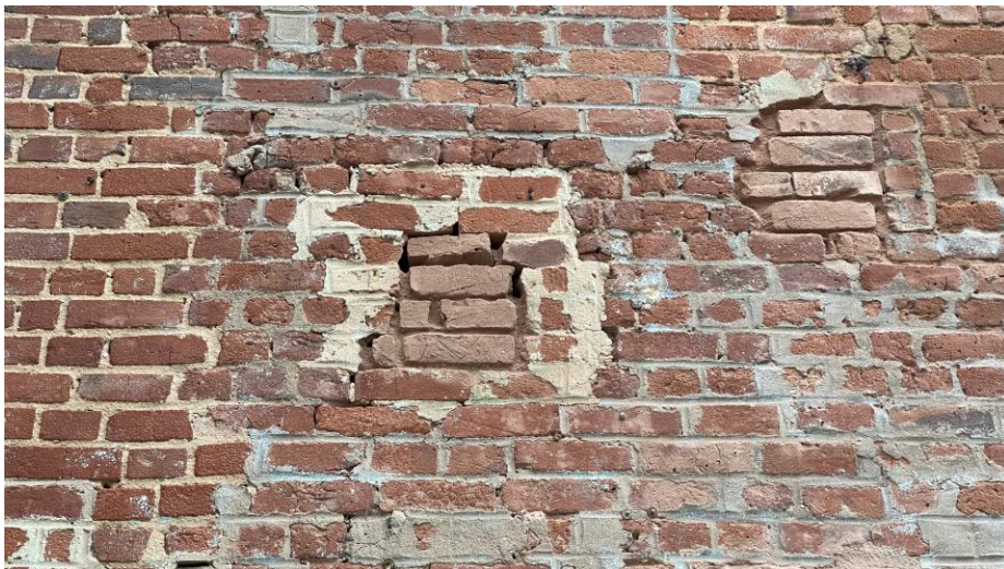
Exemple de cavités favorables présentes dans les murs du bâtiment
