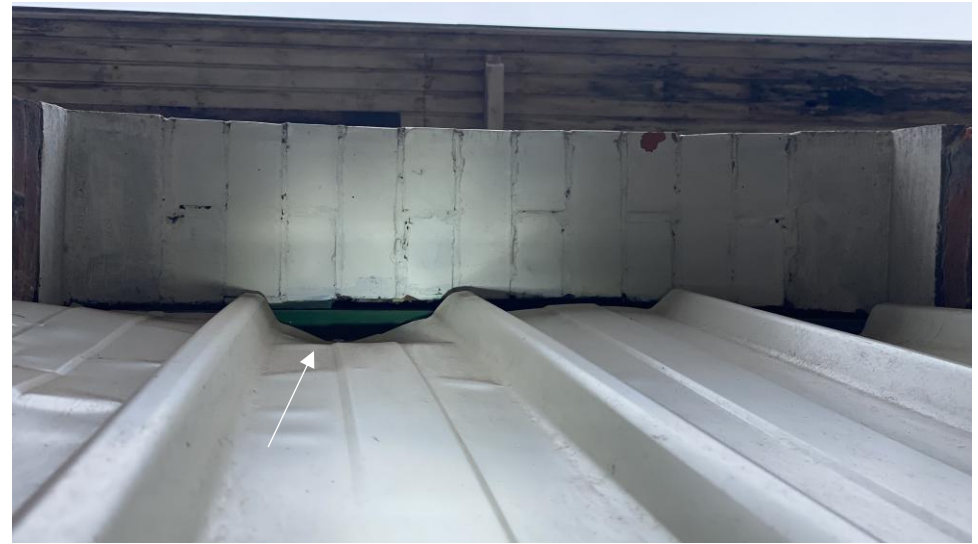
Fissures utilisables au-dessus de certaines fenêtres et des portes.
