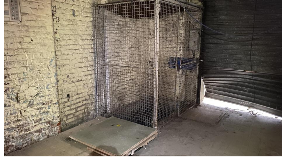
Accès au sous-sol possible par l'intérieur du bâtiment qui est largement ouvert.
