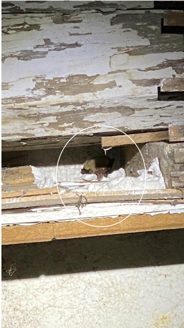
RDC : Oreillard(roux?) entre deux cloisons de protection d'un conduit
