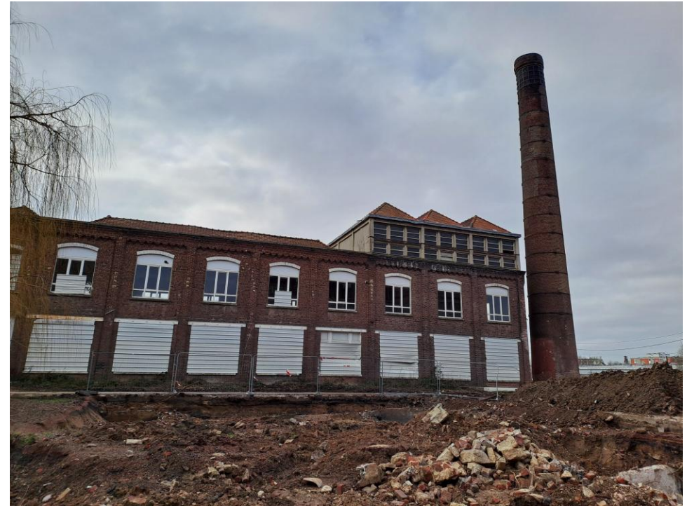
Façade est des Bâtiments 11 et 10
