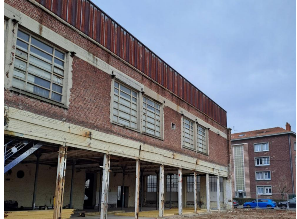
Façade sud du Bâtiment 2
