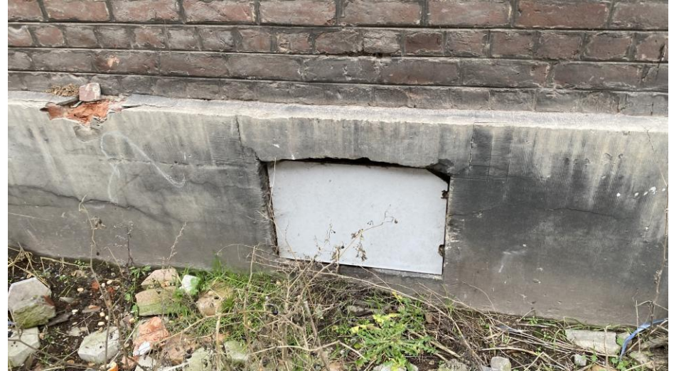
Accès fermé à la cave
