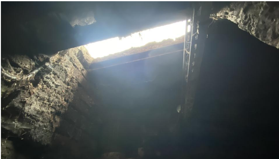
Accès situé côté rue au bout de la pièce
