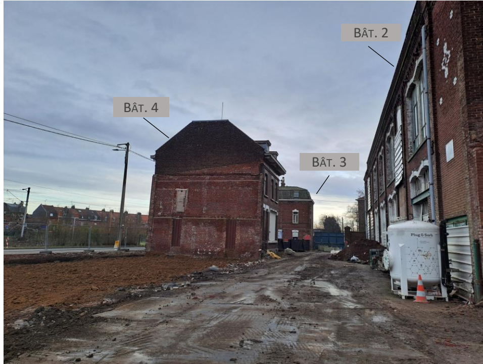
Bâtiments 2, 3 et 4 vus depuis l'ouest, à l'entrée du site
