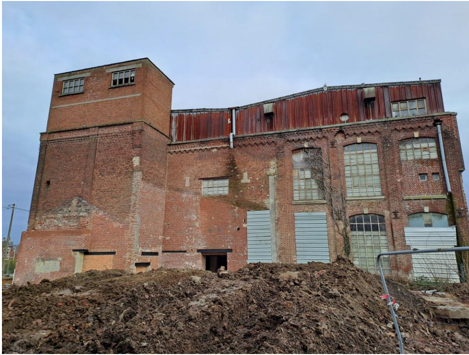
Façade ouest du Bâtiment 2
