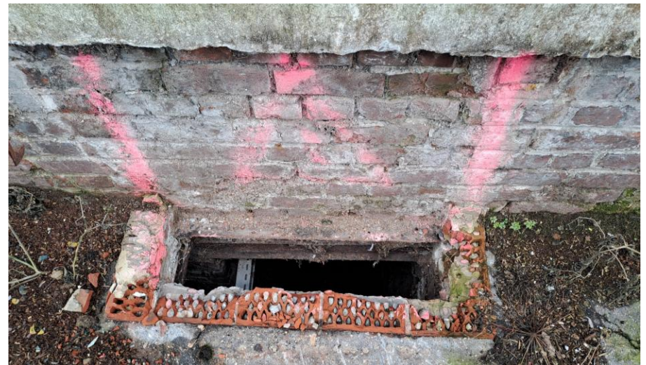
Accès au sous-sol utilisable par les chiroptères, vu depuis l'extérieur
