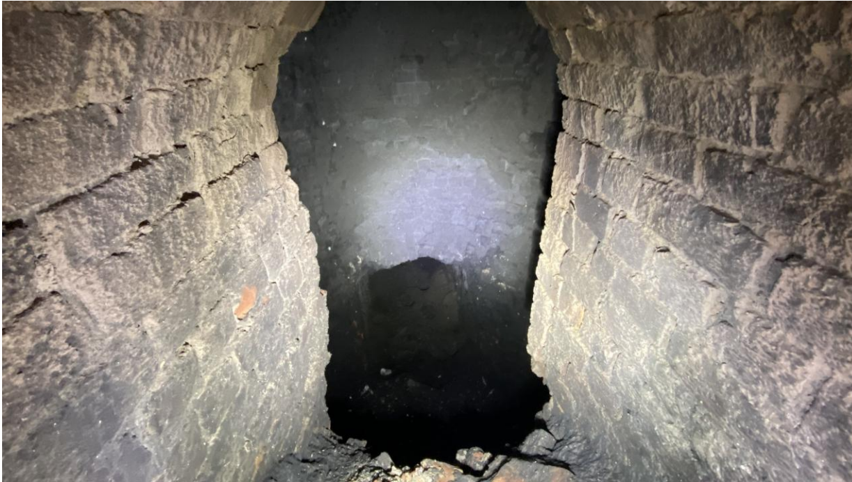
Espace intérieur visible depuis l'ouverture à la base de la cheminée
