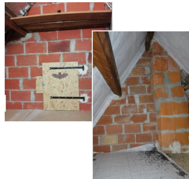
Exemple d'espace exclusif préservé et dédié aux à une maternité de Sérotines communes dans les combles d'une habitation (© Picard Nature)
