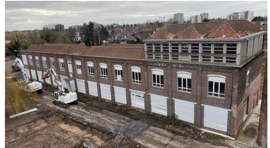
Extérieurs : la couvertine en partie décollée crée des habitats favorables pour les chiroptères. Il existe également des trous entre les briques à différents endroits.
