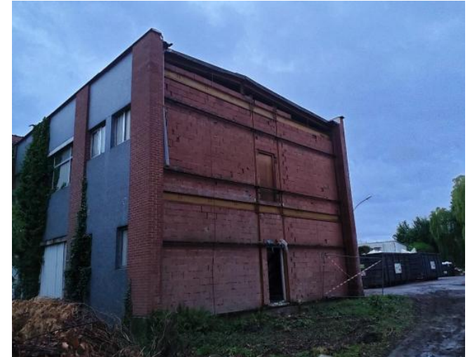
Bâtiment 12 : mur de briques creuses mis à nu par les travaux. Certaines briques fissurées sont attractives pour les chiroptères (© Biotope, Mai 2025)
