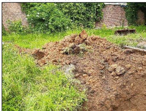
Vue n°13 : déblais de la fouille ADI 37
