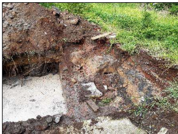
Vue n°4 : déblais de la fouille ADI 34
