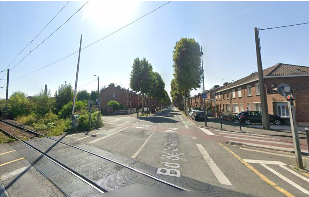
Vue sur le passage à niveau au nord du Boulevard de la République (Google Street View, août 2025)
