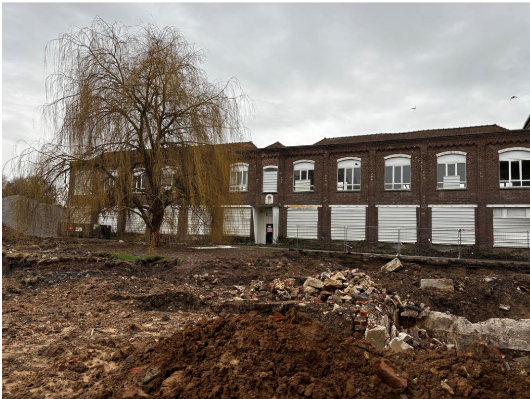
Vue sur la façade est du bâtiment 11 (Visite de site TERAQ, janvier 2026)
