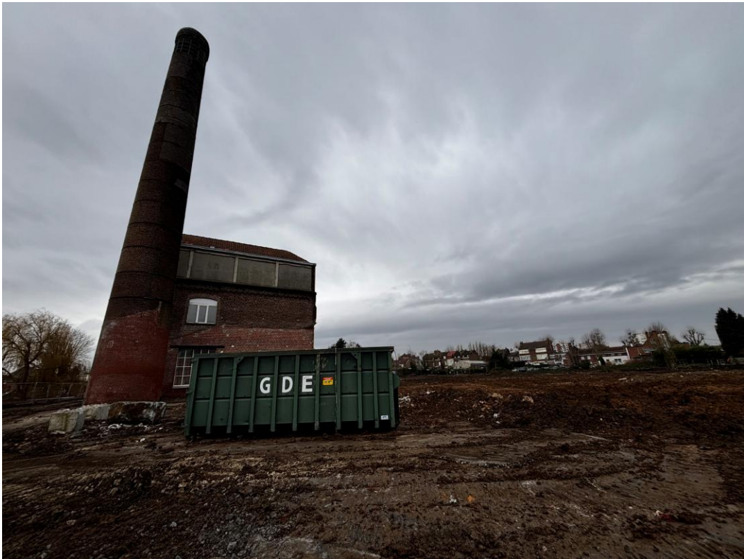
Vue sur la cheminée et le bâtiment 11 depuis l’entrée du site, rue Danton (Visite de site TERAQ, janvier 2026)
