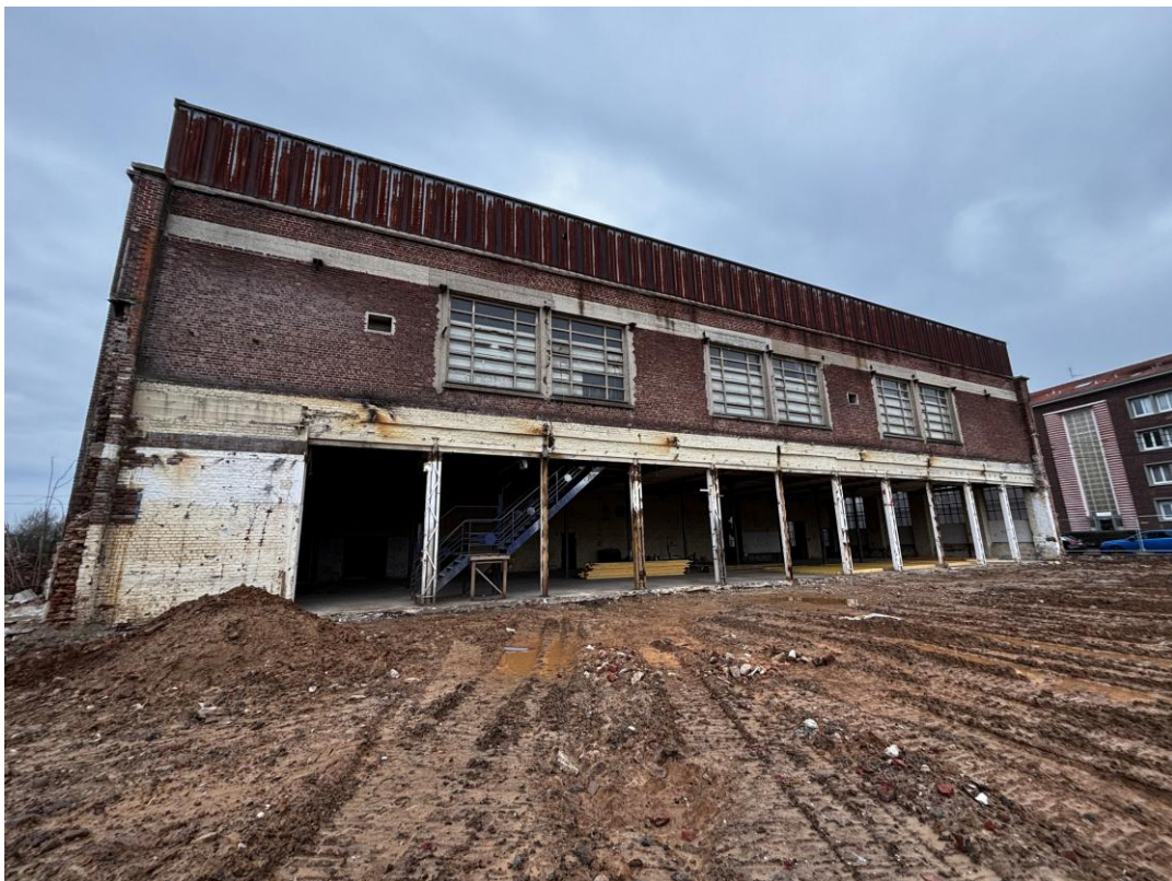
Vue sur le bâtiment 2 et sa façade sud (Visite de site TERAQ, janvier 2026)
