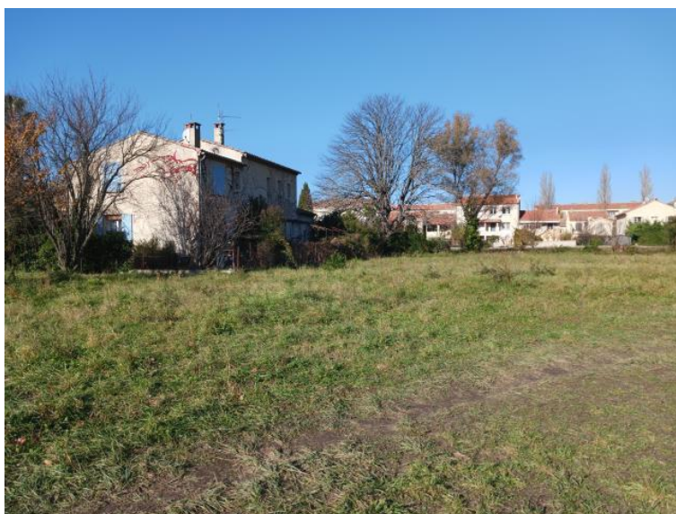
Figure 1 Vue de l'ancienne bâtisse
