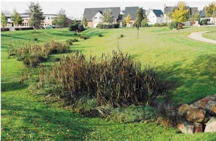
Figure 21 : Exemple de réalisation d'espace vert creux
