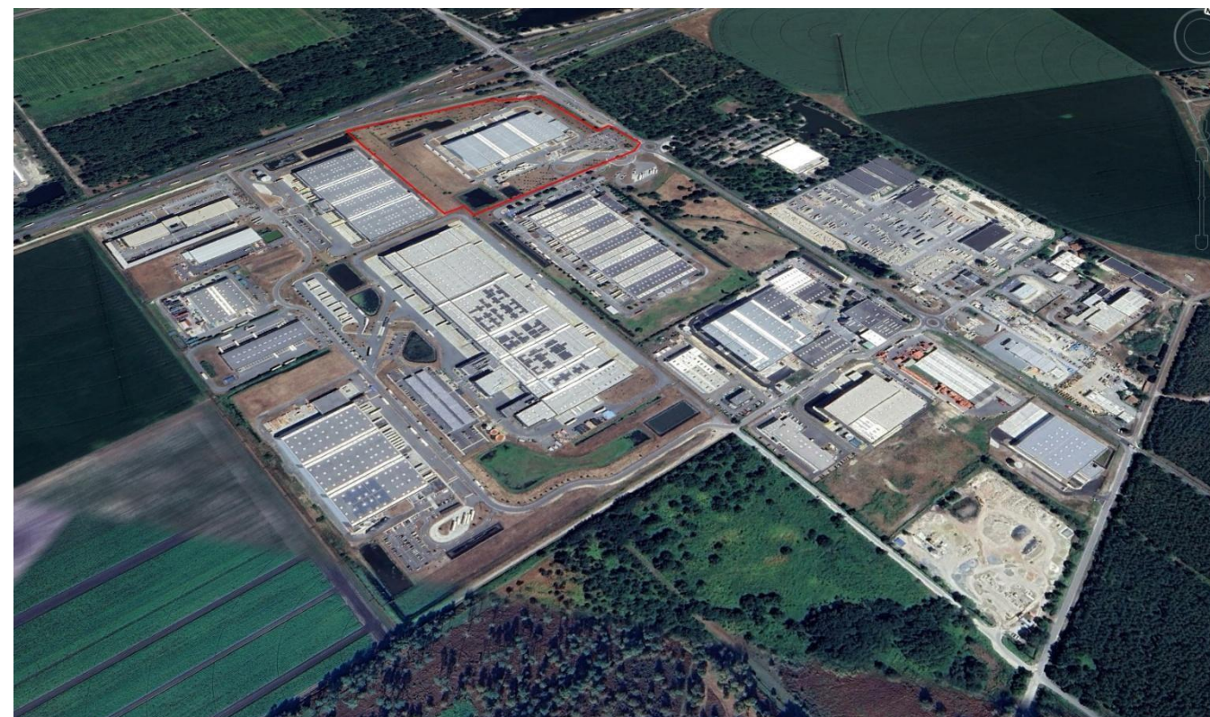
Vue aérienne du site existant
