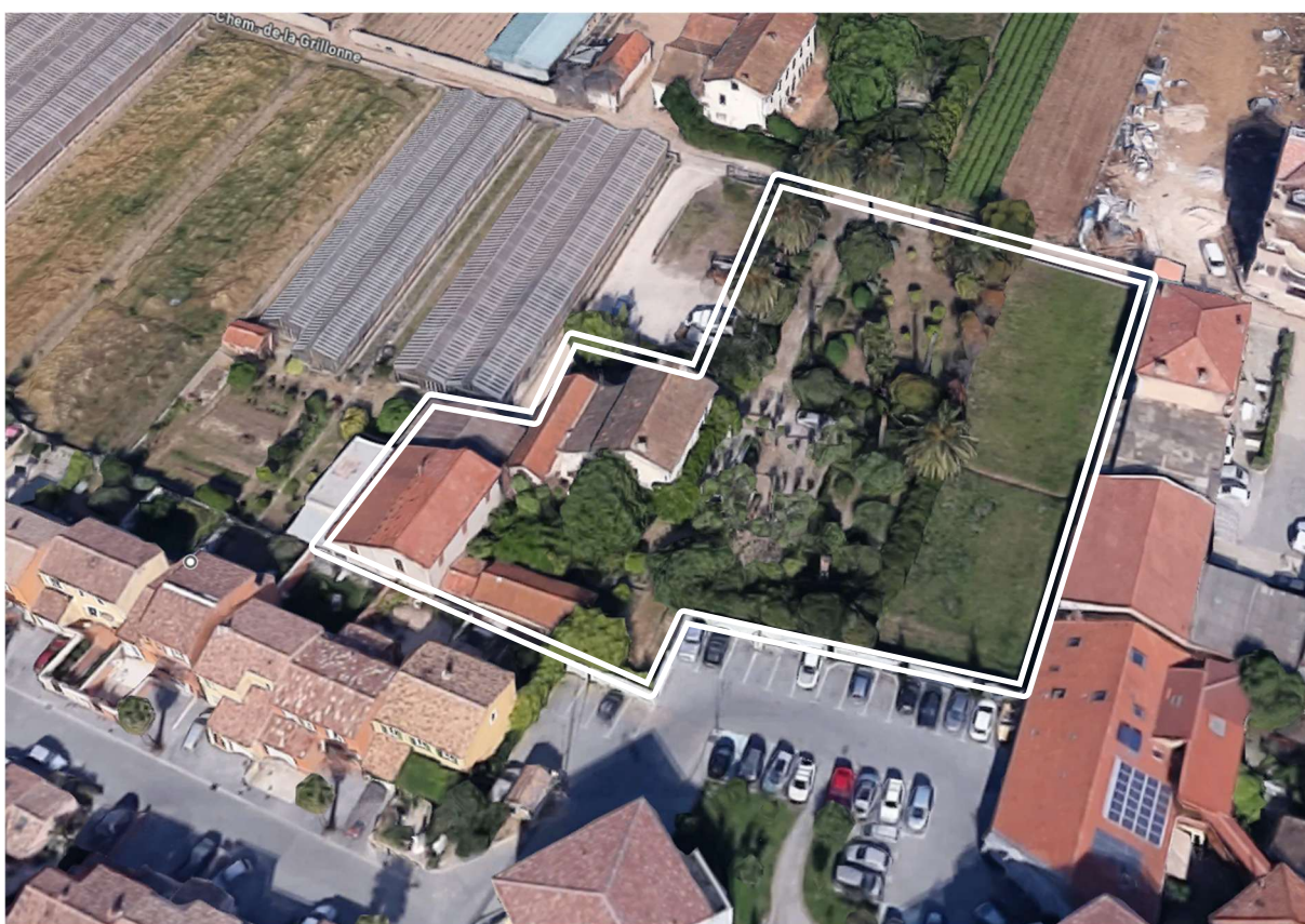
Vue 5 : Hors périmètre de projet, propriété BOUISSON conservée (janv 2023, Google Street View)
