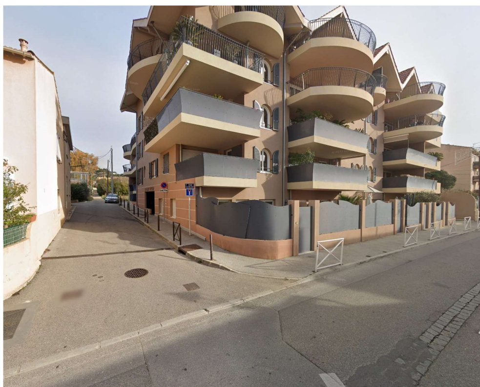
Vue 2 : angle chemin de la Grillonne / avenue Jean Jaurès, illustration du tissu urbain existant à proximité directe du périmètre de projet (janvier 2023, Google Street View)
