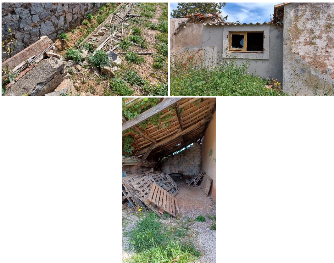
Photo 13-16 : Site de refuge potentiel pour les reptiles (Even, 2023)
