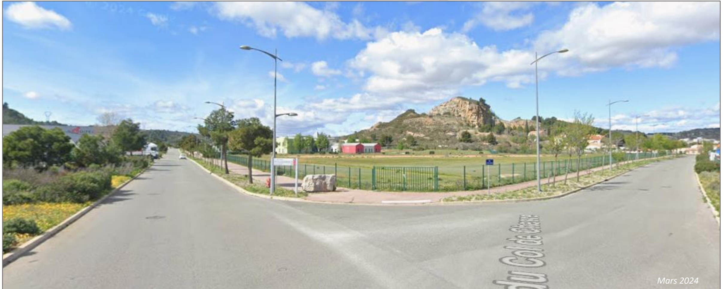
Ombrière bassin Environnement proche (1)
