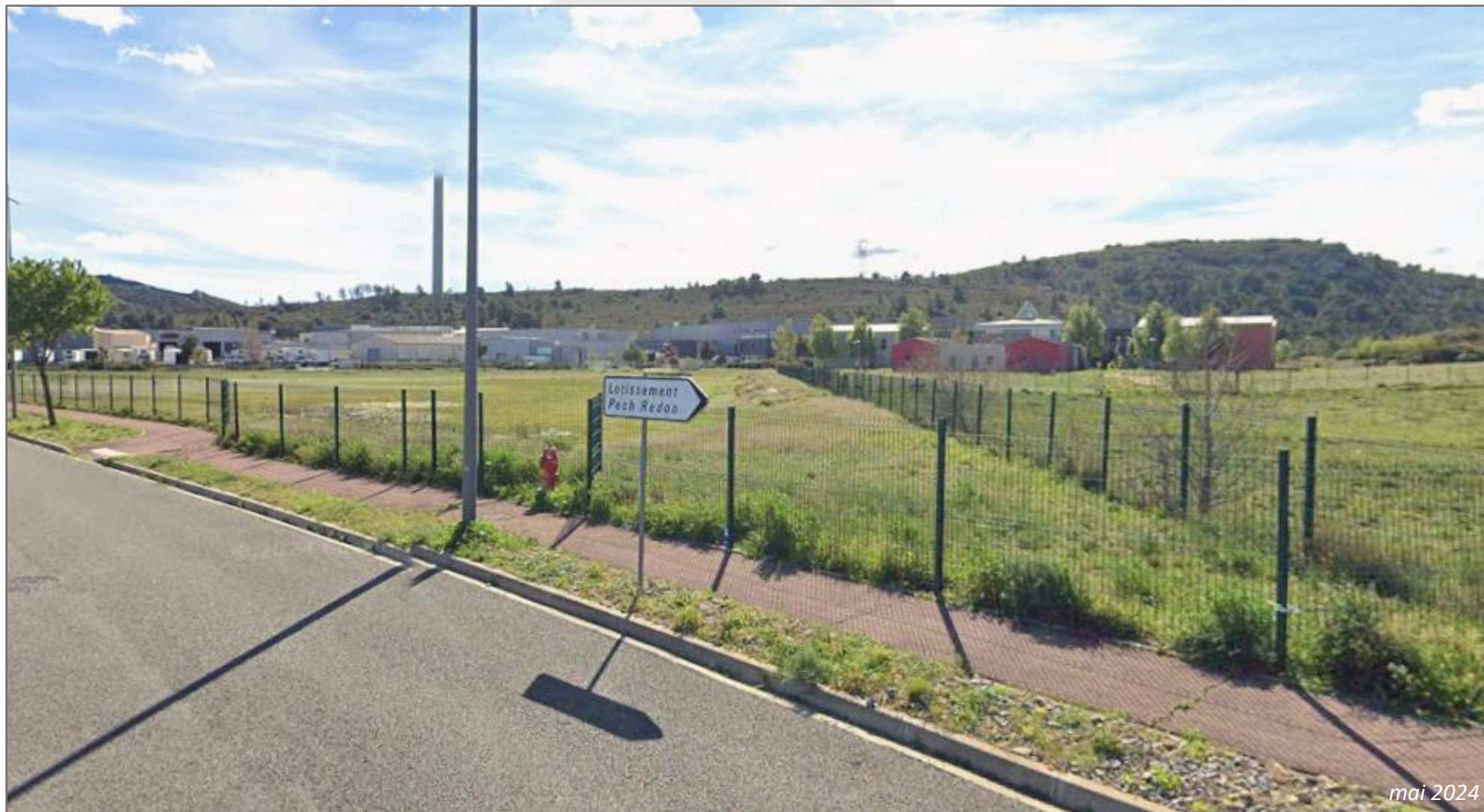
Ombrière bassin Environnement proche (2)
