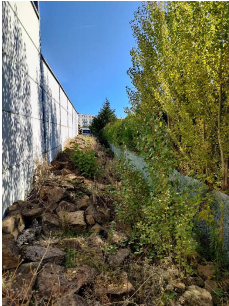
Bande de rochers / rocailles (Sud du bâtiment)
