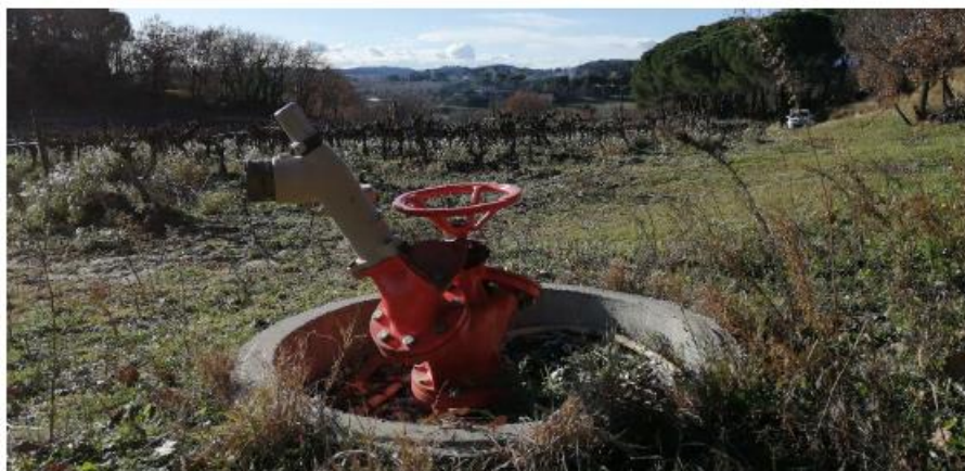
Bornes d'irrigation
