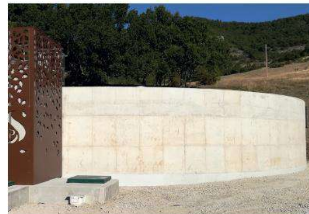
réservoir de Sisteron - Bois de bûche. Texture et aspect de l'anneau inférieur.
