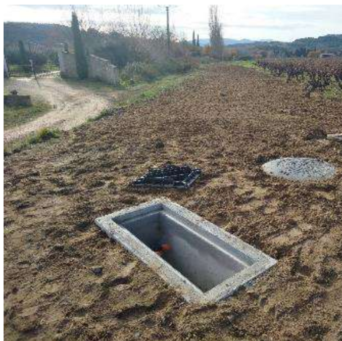
Fin de chantier (décembre 2020)
