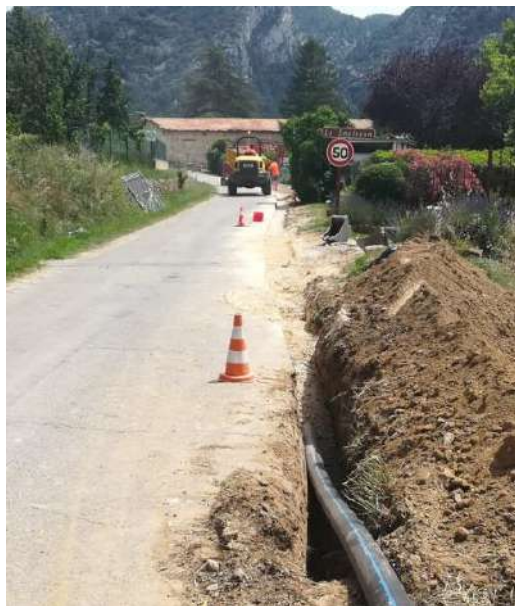
Pendant les travaux de pose
