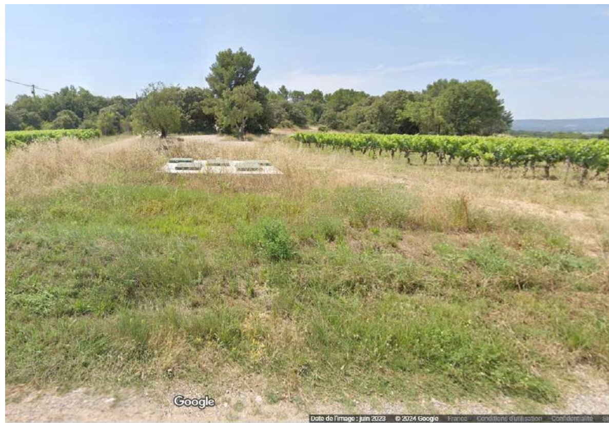
Regard de sectionnement (15m 2 )
