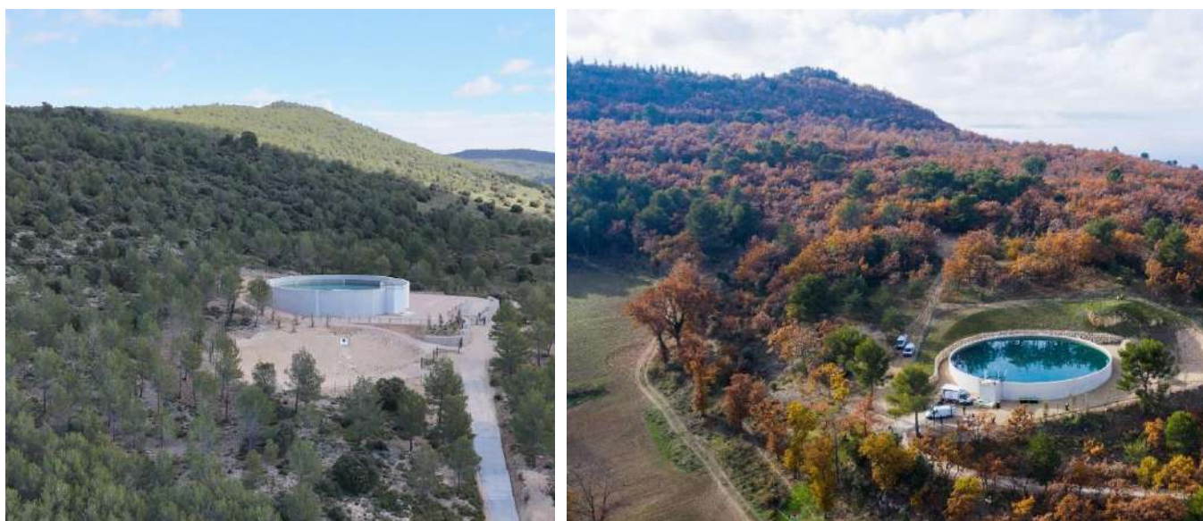
Figure 4. Vues sur des réservoirs similaires (Mirabeau 2024 et Apt 2021)
