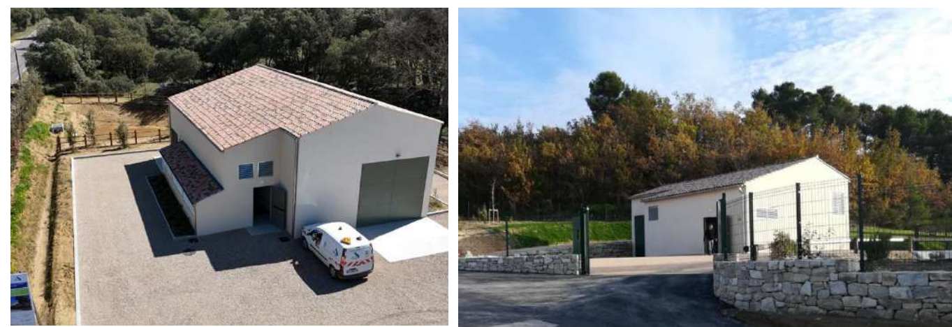
Figure 5. Vues sur des stations de pompage similaires (Mirabeau 2024 et Apt 2021)
