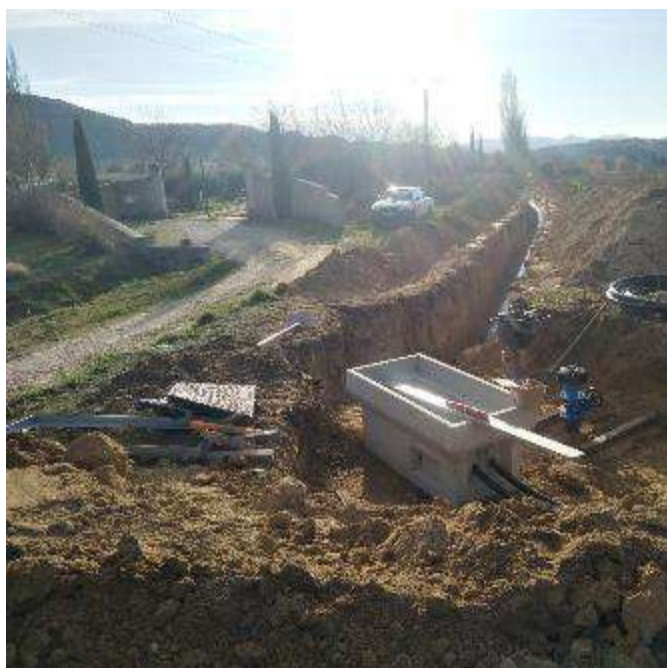
Pendant le chantier (décembre 2020)
