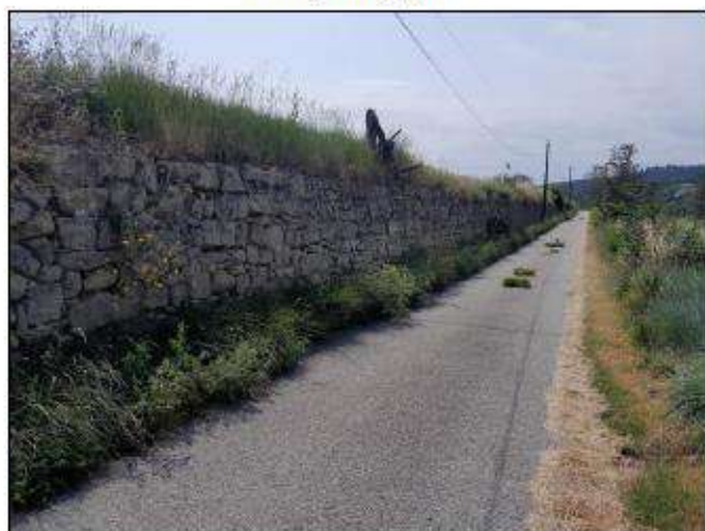
Muret où a été observé le Lézard ocellé
