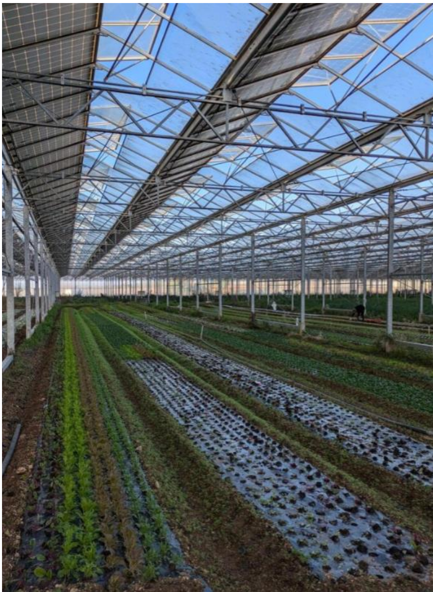
Figure 9 : Serre photovoltaïque de la S.A.R.L DEVERS réalisée par Technique Solaire
