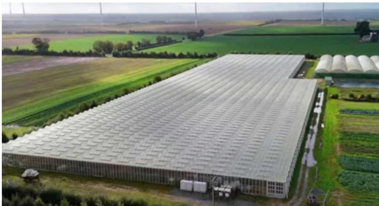
Figure 8 : Serre photovoltaïque de Monsieur Devers. Source : Technique Solaire
