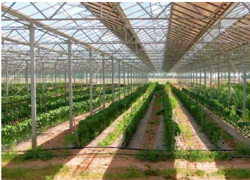
Figure 2: Serre photovoltaïque de la S.A.R.L DEVERS réalisée par Technique Solaire
