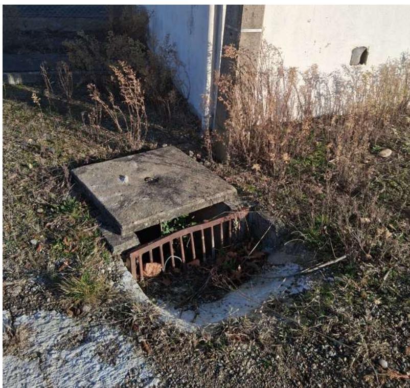
Grille pluviale en partie obstruée
