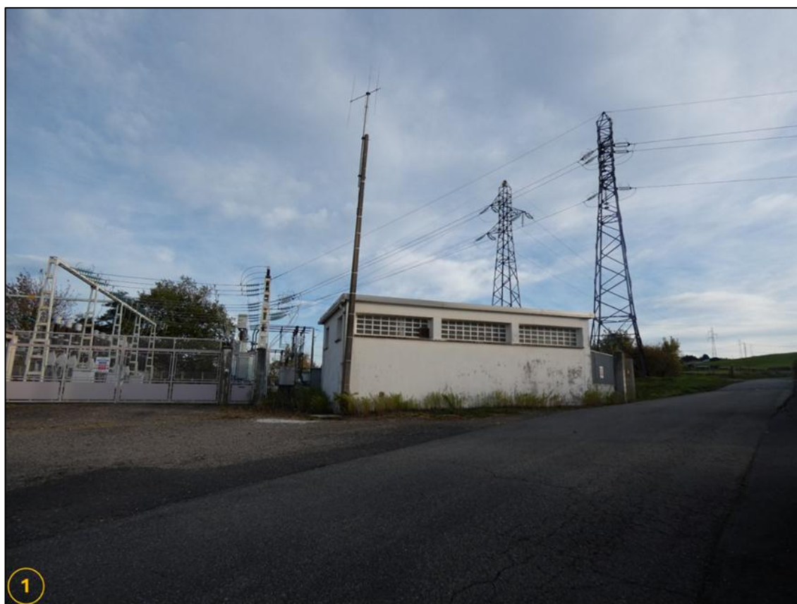
Annexe 4 : Photographie du site et de ses abords (06/10/2025)
