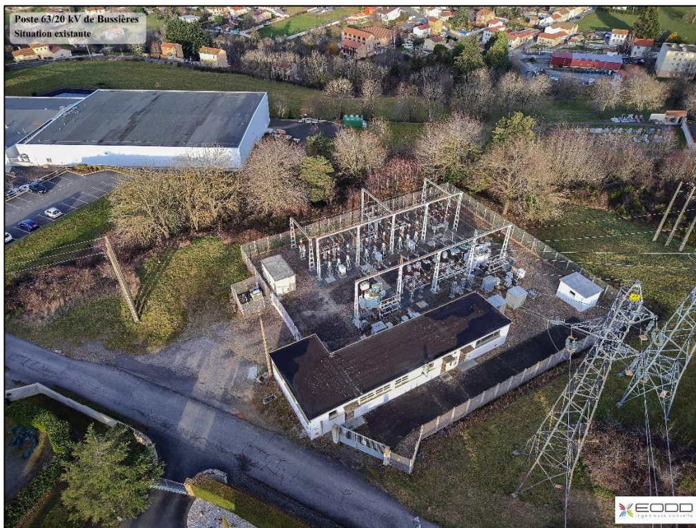
Illustration 5 : Vue aérienne du poste existant
