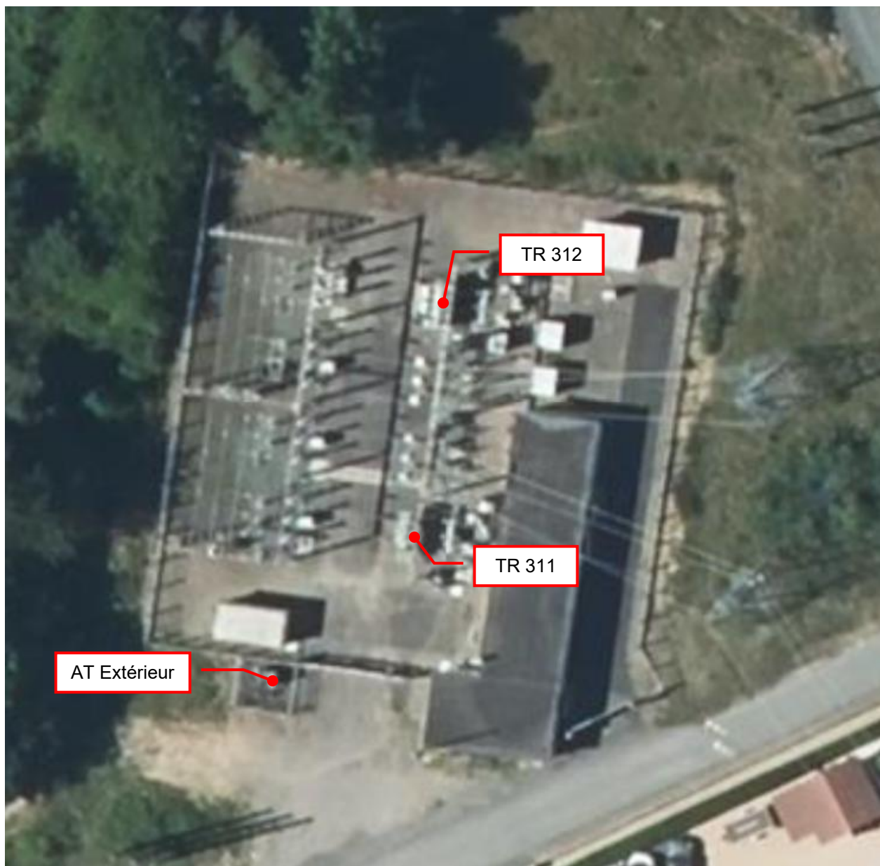
Figure 3 : Localisation des transformateurs dans l'enceinte du PS
