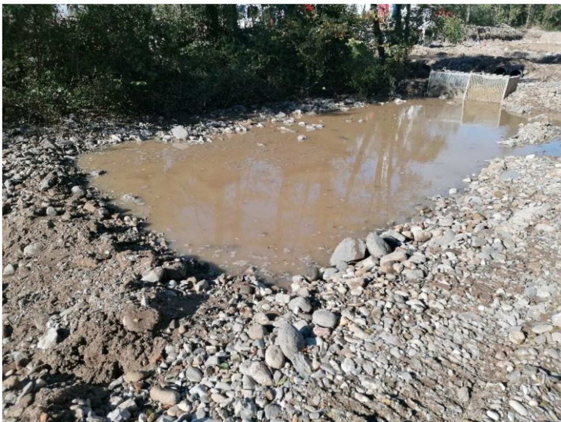
Figure 14 - Cage gabion remplie de paille décompactée suivi d'un bassin de décantation, chantier sur l'Ouvèze, HYD 2021
