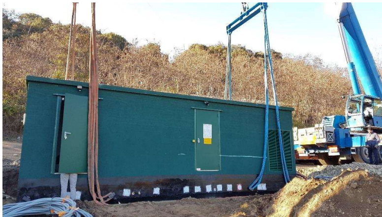
Figure 4 : Photographie de l'installation d'un local technique
