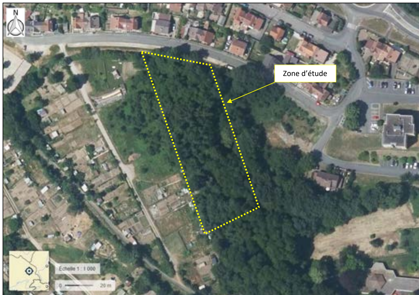
Figure 2 : Vue aérienne du site datant de 2021 au 1/1000, Géoportail (IGN)
