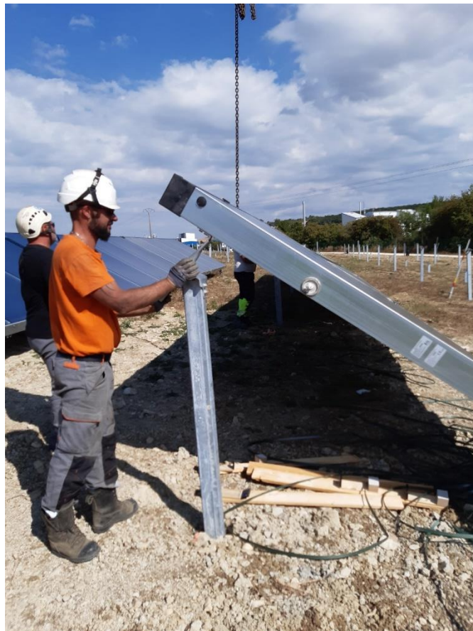
Figures 6 : Elingage Installation des capteurs thermiques sur pieux supports
