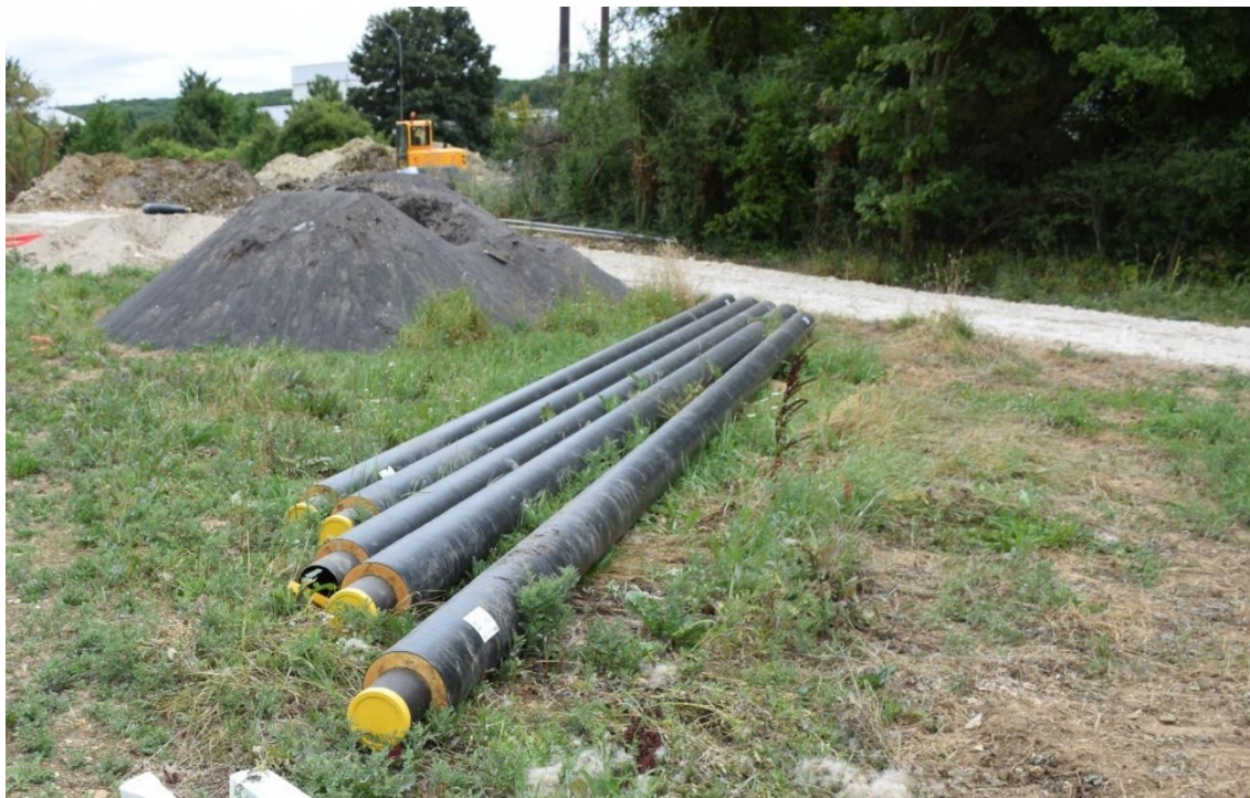
Figure 7 : Exemple de tronçons de tuyauterie pré-isolée
