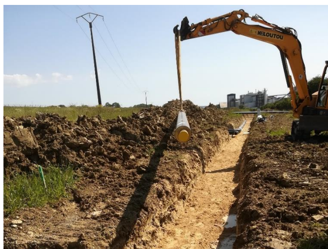
Figure 14 : Exemples de réalisation de tranchée avec pose de la tuyauterie enterré
