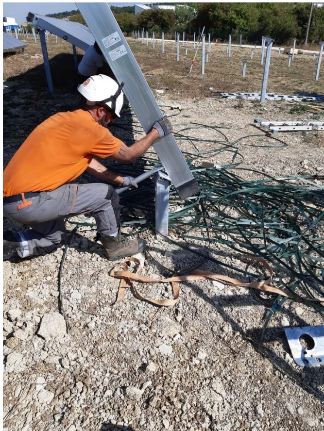
Figures 6 : Elingage Installation des capteurs thermiques sur pieux supports
