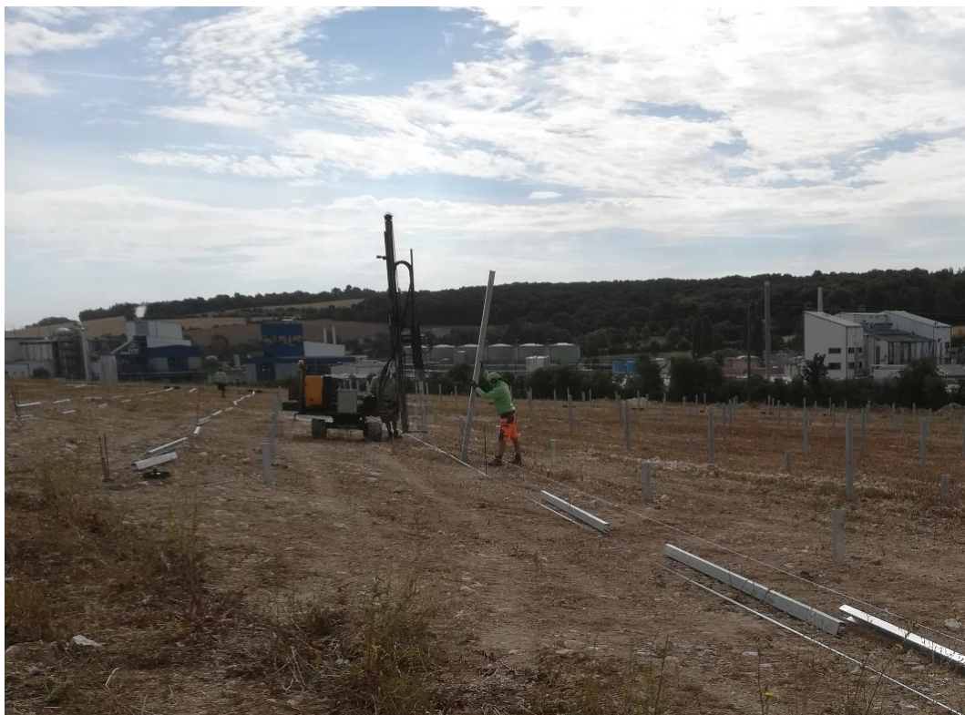
Figure 15 : Battage des pieux supports des capteurs
