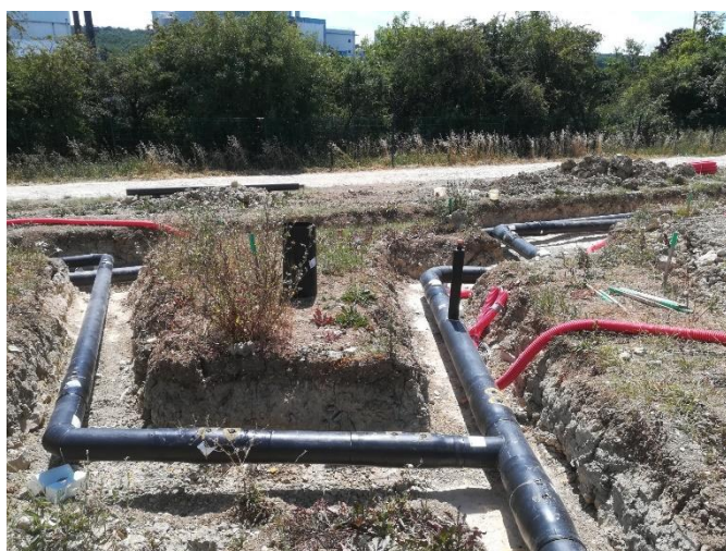
Figure 14 : Exemples de réalisation de tranchée avec pose de la tuyauterie enterré
